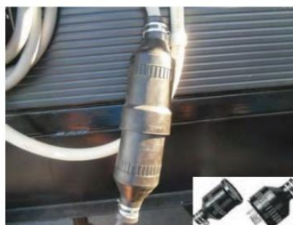
⑧電気配線の接続方法が工具を使用せずに着脱出来る方式であること。
