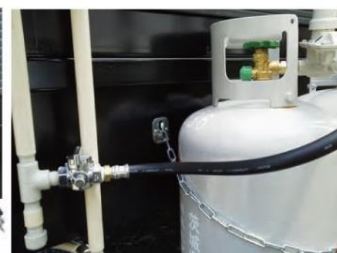
⑨ガスボンベがトレーラーハウスに積載されているかまたはレンチで簡単に着脱できること。
