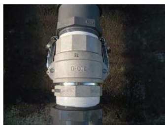
⑦排水管の接続方法が工具を使用せずに着脱出来る方式であること。
