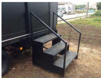
⑤「階段・デッキ」が独立した構造体であり、トレーラーハウスの移動に支障がないこと。
