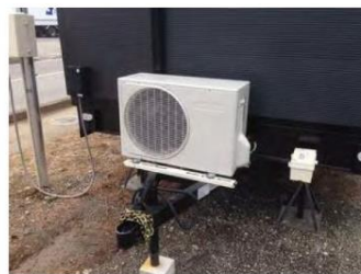
⑪エアコン等の室外機がトレーラーハウスに積載されていること。
