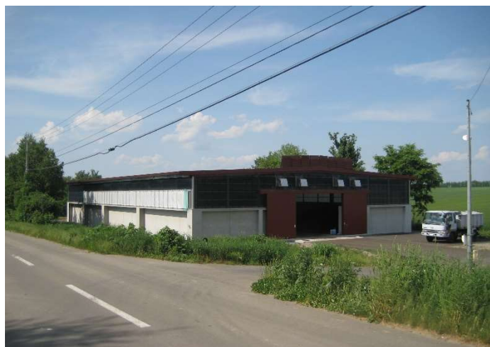
下水汚泥コンポストヤード (字北瑛第2)
